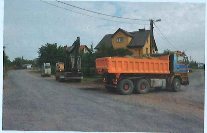
Budowa ulicy Armii Ludowej
