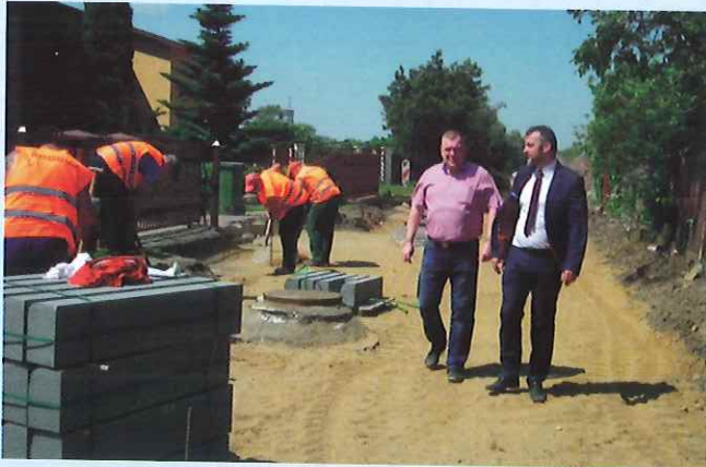
Budowa ulicy Kasztelańskiej
