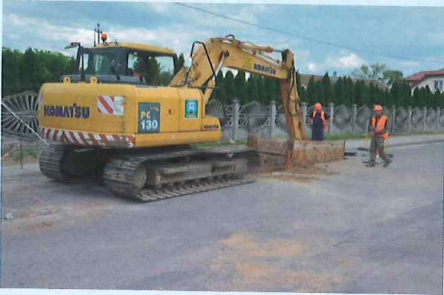
Budowa ulicy Narutowicza
