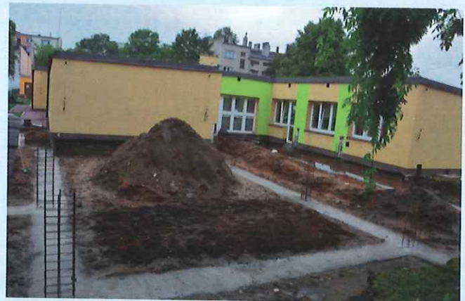
Rozbudowa Miejskiego Przedszkola Nr 3
