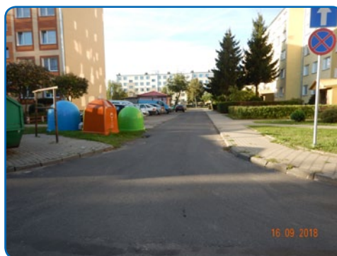
Zrobiono nową nawierzchnię asfaltową przy bloku Nr 32 (Osiedle Jana Pawła II)
