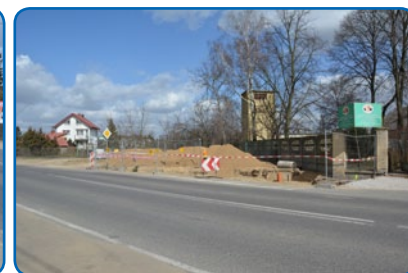
I etap budowy ul. Płockiej zakończony
