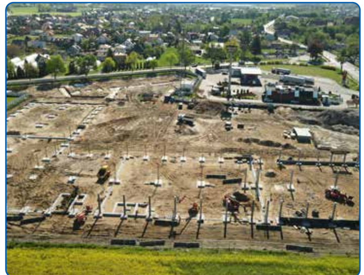
Budowa Stacja Sierpc - Retail Park
