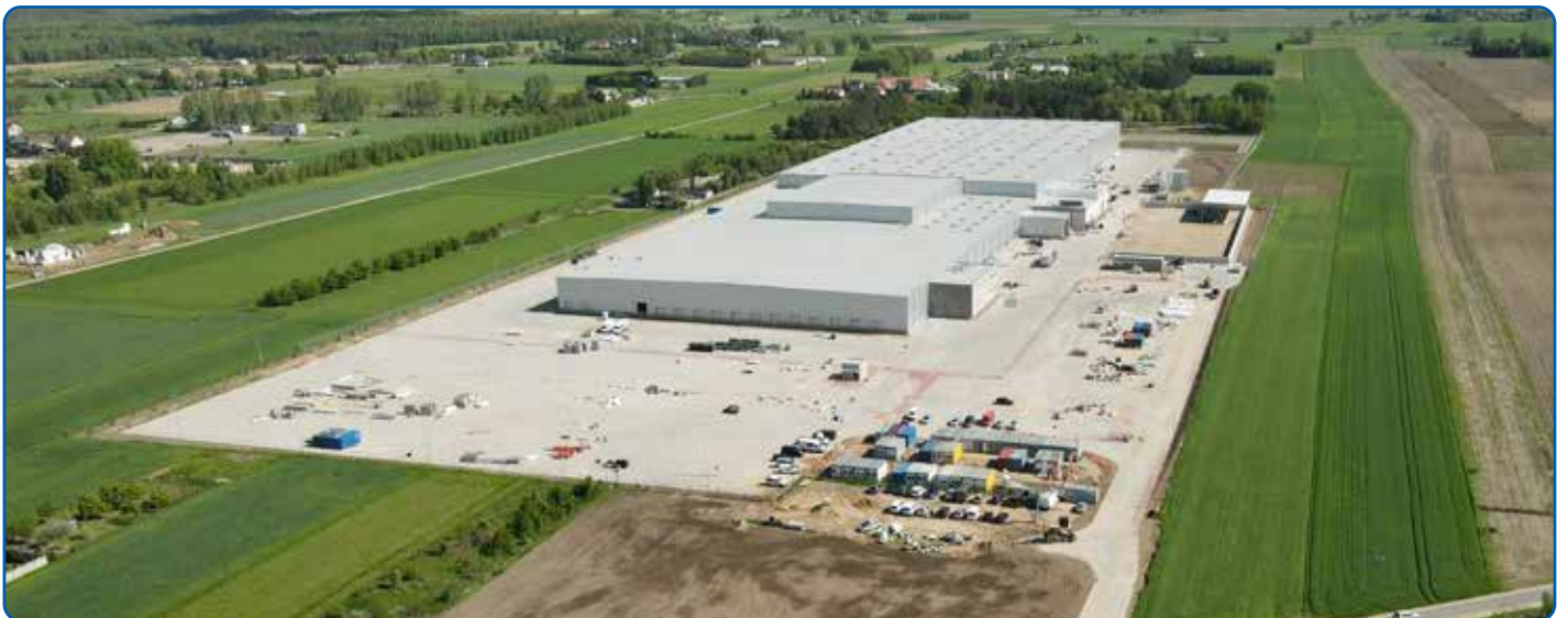
Budowa centrum logistycznego DINO Polska S.A.
