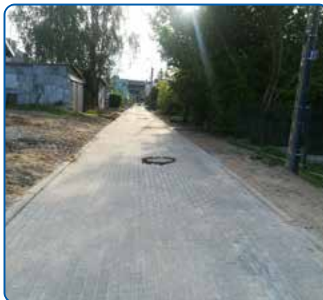
Budowa ulicy Marii Konopnickiej
