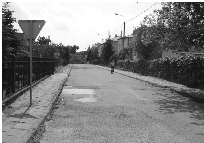
Chodnik na ulicy Gałczyńskiego przed remontem.
