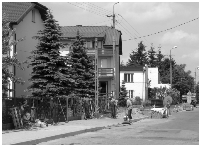
Remont chodnika przy ul. Sienkiewicza.
