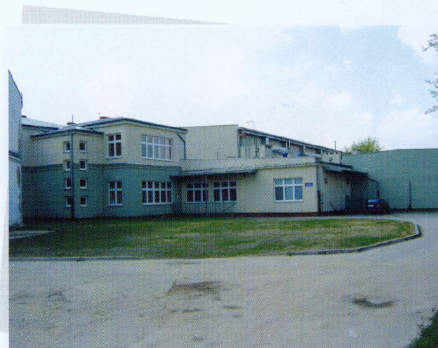
Tak wygląda hala sportowa przy Sz. P. Nr 2 od strony ul. Płockiej – po rozbiórce budynku, przy ul. Płockiej 38.
