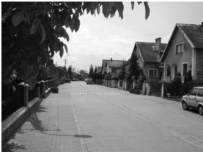
Ulica Warneńczyka po zakończeniu robót drogowych.
