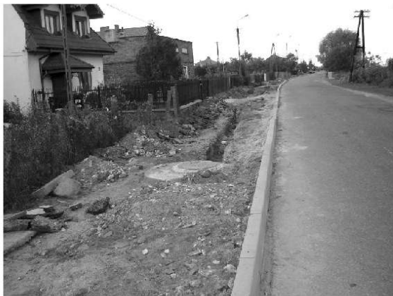
Trwają prace przy ul. Staszica.
