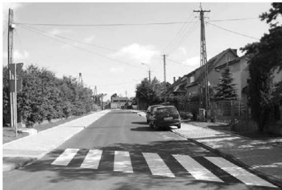
... i po przebudowie.
