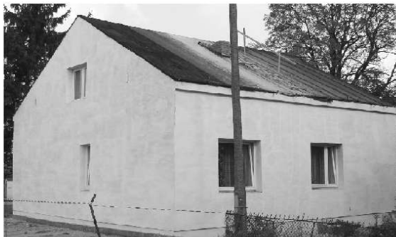
Filia Biblioteki przy ul. Narutowicza podczas remontu.
