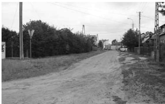
Ul. Księcia Witolda przed przebudową..
