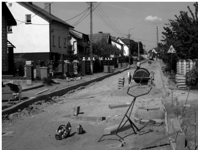
Przebudowa ul. Jana III Sobieskiego.
