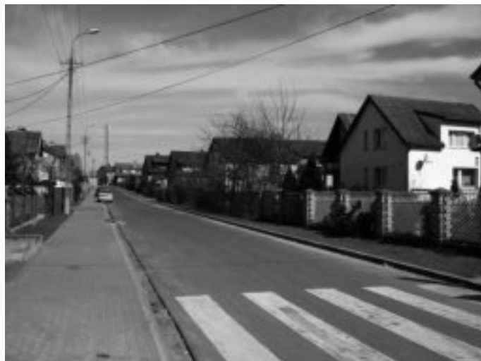
Ulica Jana III Sobieskiego po remoncie.
