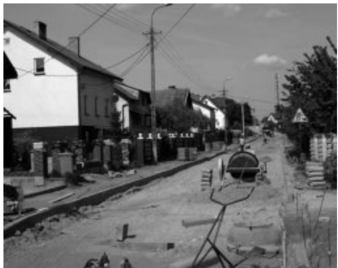
Ulica Jana III Sobieskiego w czasie remontu.
