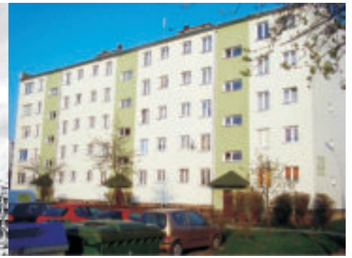
Blok przy ul. Piastowskiej 20.
