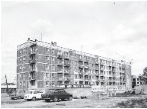
Jana Pawła II 16 w czasie budowy.
