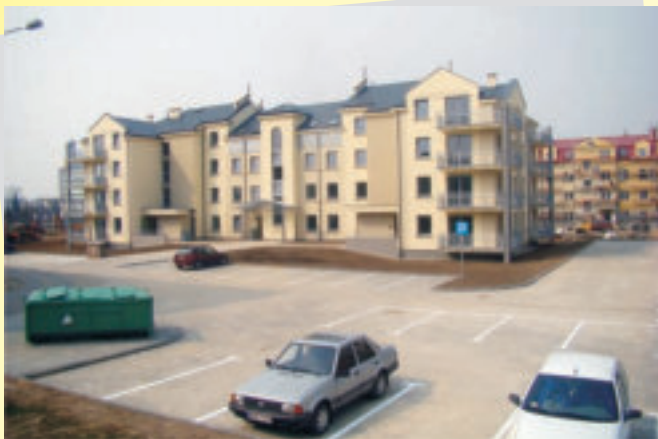
Nowy wielorodzinny budynek przy ul. Witosa 1.
