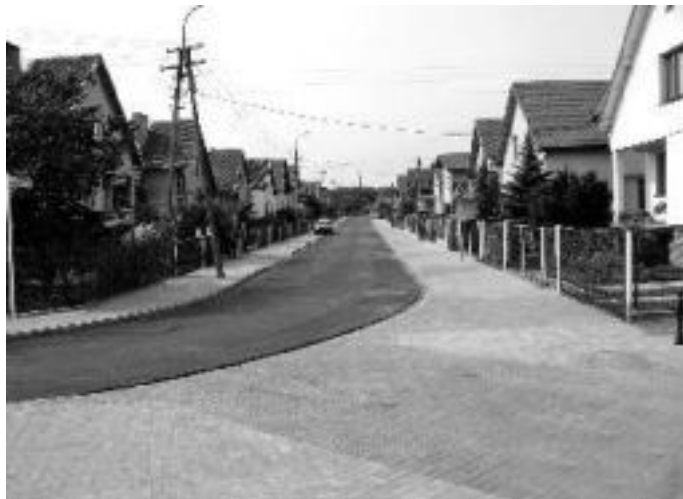
Ulica Zawiszy Czarnego po przebudowie.
